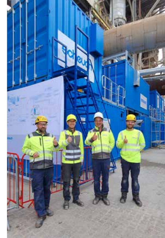
Bevor CO 2 abgeschieden werden kann, wird das Abgas in einer Scheuch Gasvorreinigungsanlage gründlich gereinigt.
