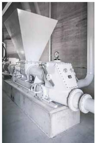
Les **PRODUITS DE RÉACTION ET LA POUSSIÈRE** sont transportés vers le silo à matières résiduelles où ils sont stockés jusqu'à leur enlèvement par camion. Le transport jusqu'au silo peut s'effectuer par voie pneumatique ou mécanique, selon les exigences.
