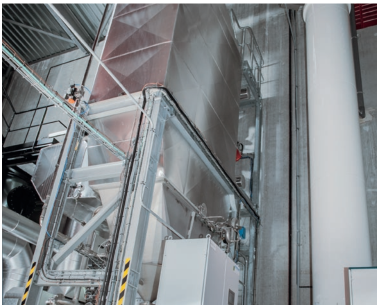
Chaleur utile pour la fourniture de chauffage urbain Nom du projet : Etouvie Pays : France Modèle : ercs – TYPE 02 Puissance de la chaudière : 5 MW
