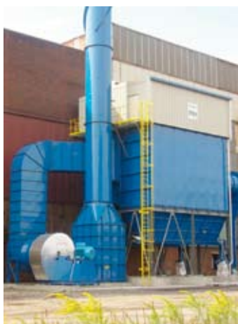
Filtres en lignes dans l'industrie de la fonderie
