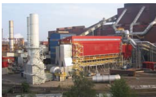
Filtres à chambres dans l'industrie de l'acier
