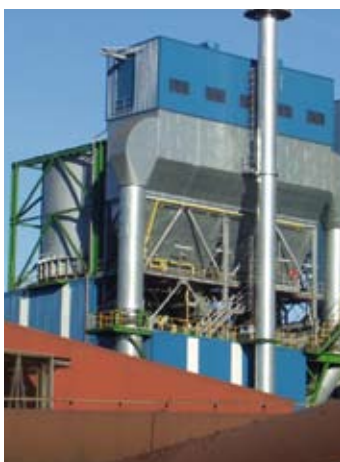
Filtres résistant aux coups de bélier pour le dépolluage d'une installation de broyage du charbon
