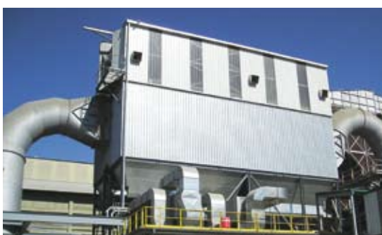
Filtres à chambres dans l'industrie du ciment
