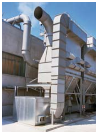
Filtres en lignes dans l'industrie des matériaux dérivés du bois
